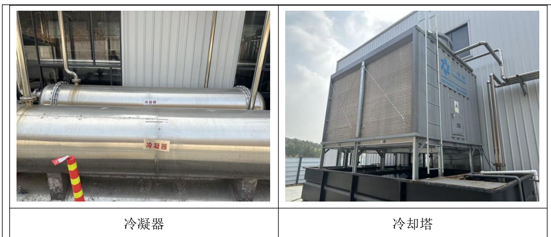
图 3-4 废气处理工设备
